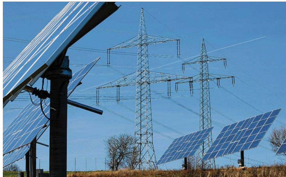
Erneuerbare Energien verändern die Region Ostfriesland.
